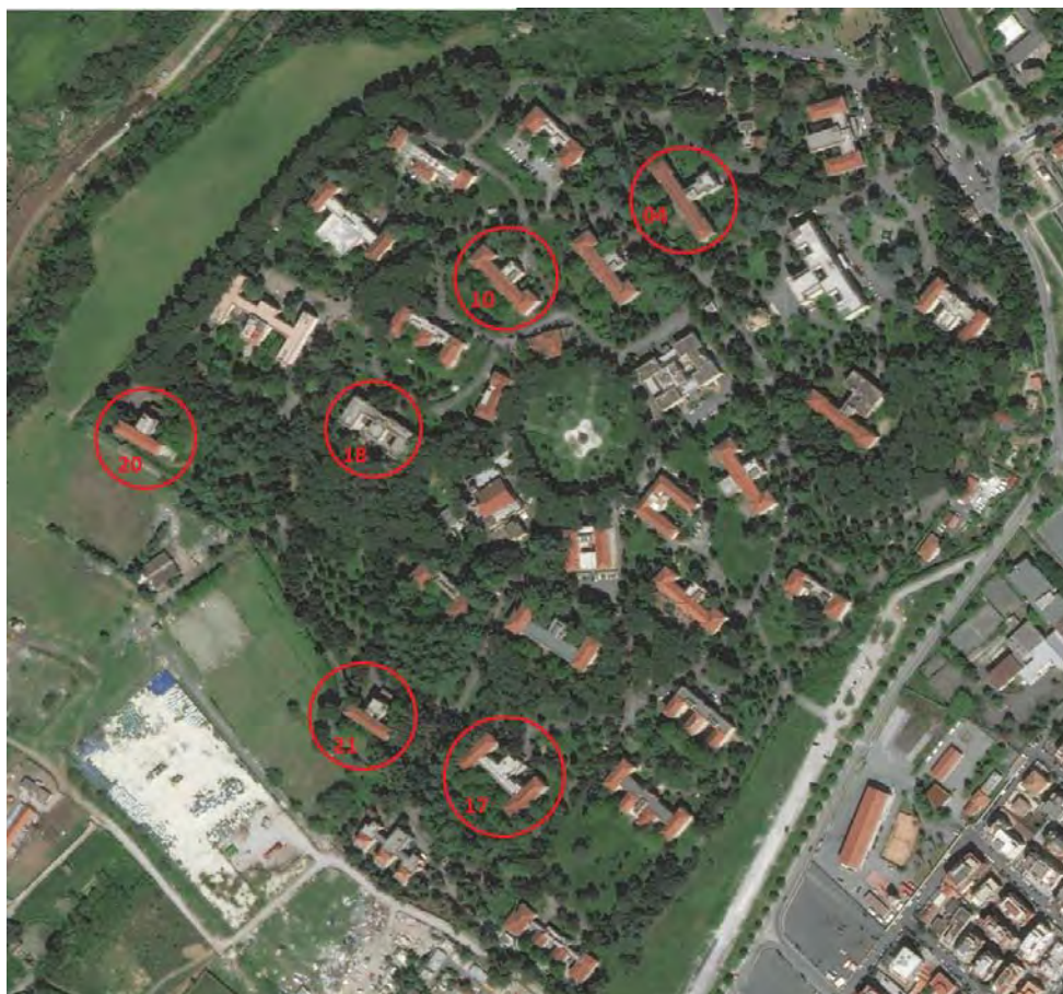
Aerofoto del complesso con cerchiati i padiglioni oggetto di intervento
